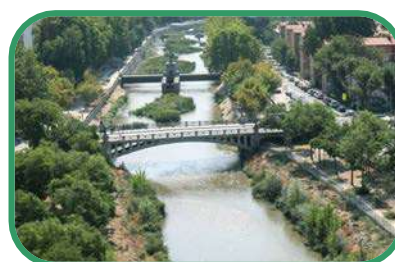
Río Manzanares a su paso por Madrid. Fuente: elpais.es.
