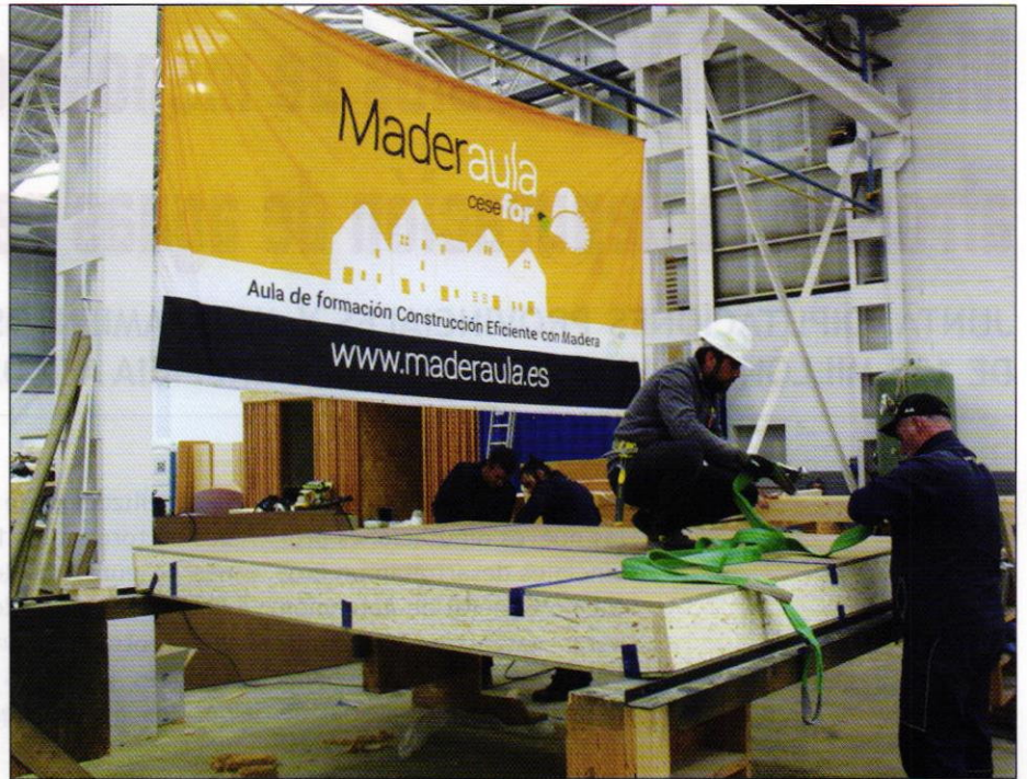
Cesefor ofrece formación sobre construcción eficiente con madera.
